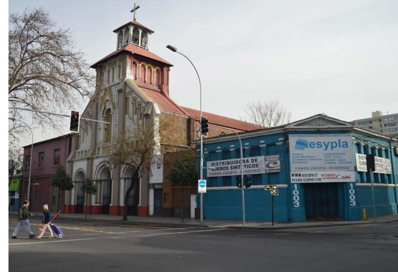
Fotografías de Edificios con modificaciones por usos comerciales. 2016.
