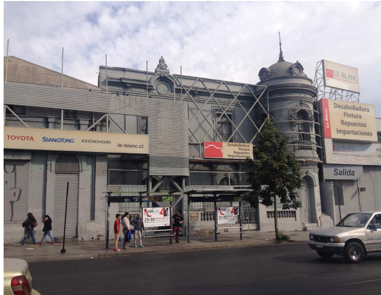
Fotografía de Edificación sobre avenida Matta, llegando a San Francisco, dónde aparecen ya los paraderos de micros, se observan los vehículos. Fuente elaboración propia.
