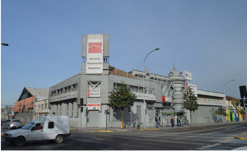
Edificio esquina San Francisco-Av. Matta, Taller Le-Blanc. 2016.
