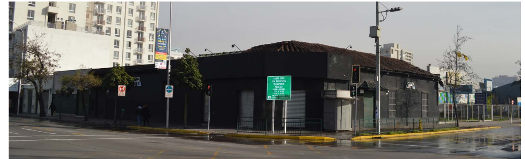
Fotografía edificación Calle Santa Rosa esquina con avenida Matta, 2016.
