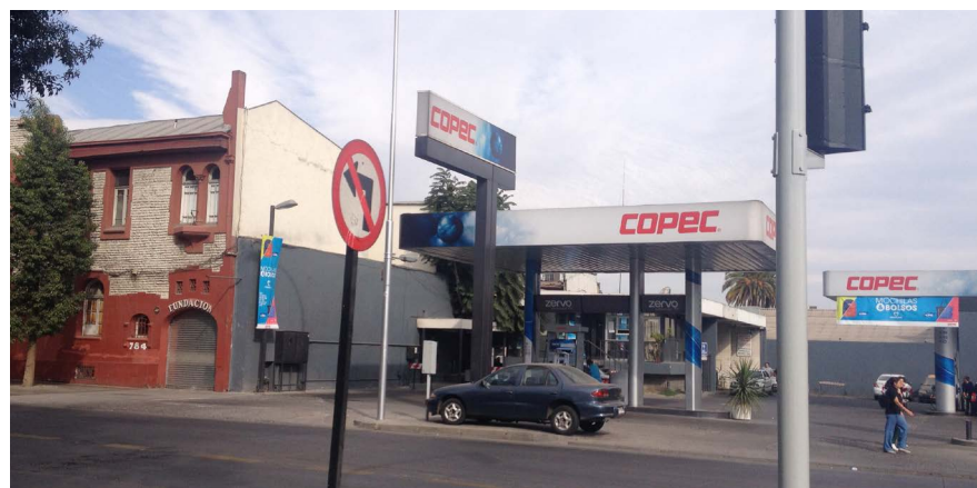
Fotografías de Estación de Servicio (bencinera) ubicada en Avenida Matta, esquina San Francisco, superior tomada año 2016, inferior tomada año 2014.
