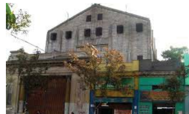
Demolición del cine (o cinerama) Santa Lucía. Fuente: http://www.35milímetros.org/el-ultimo-cinerama-santa-lucia/
