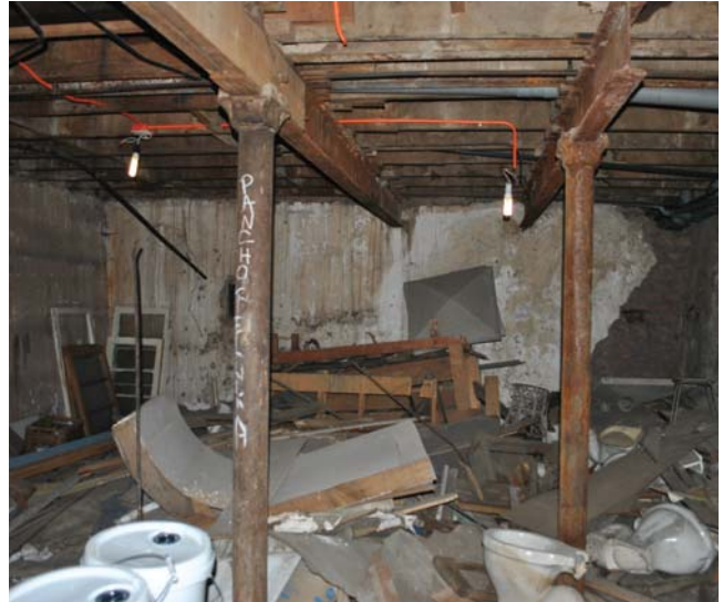
1.2. Pilares de apuntalamiento
