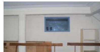
Ventana de sala cuna, antigua abertura de proyección
