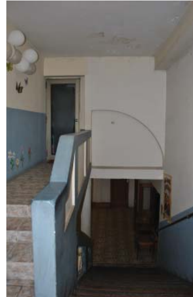
Vista hacia sala de proyección sobre el hall de acceso, se observa un medio arco oculto que probablemente configuraba la escalera hacia los palcos del 2° piso.
