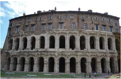
Teatro di Marcello, Roma, Italia. Vista fachada del teatro.
