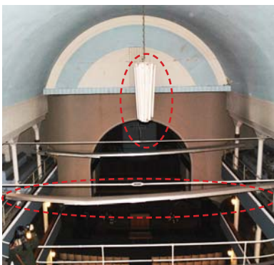
Eliminación del sistema eléctrico (lámparas y tubos fluorescentes)
