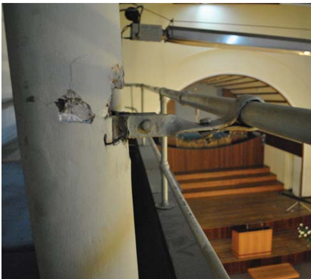
2.3. Revisión estado de conservación pilares 2.4. Restauración barandas
