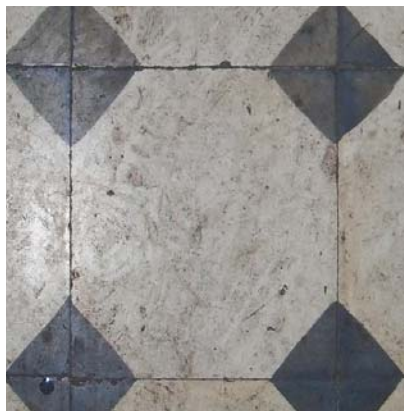
Baldosas hidráulicas cocina escuela dominical
