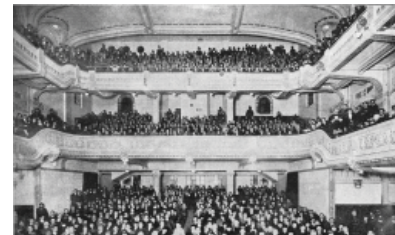
Teatro Carrera (1926). Salón principal con planta en "U"; en la fotografía se observan los palcos en 2° y 3° piso (paralelos y perpendiculares al escenario) y la galería en el último nivel. Fuente: http://www.memoriachilena.cl/archivos2/thumb750/mc0029439.jpg
