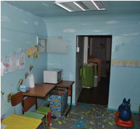
3.1/3.2 Recuperación de pavimentos y muros
