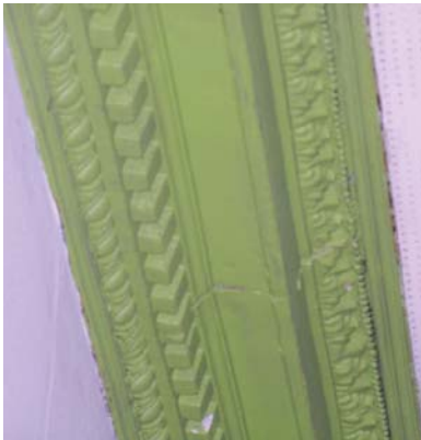
Vista de elemento cornisa, se observa el detalle del trabajo en yeso.
