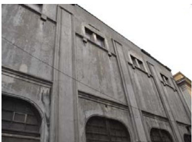
Fachada Volumen Salón Principal, conserva el color de la materialidad del muro.
