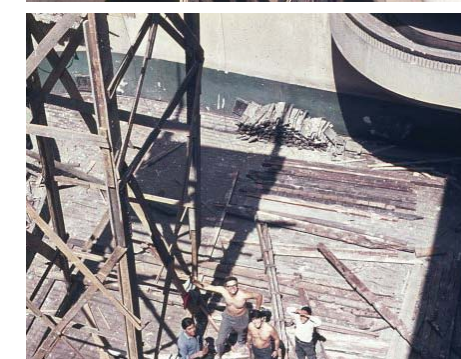
26. Remodelación de la antigua techumbre del ex teatro, año 1969.
