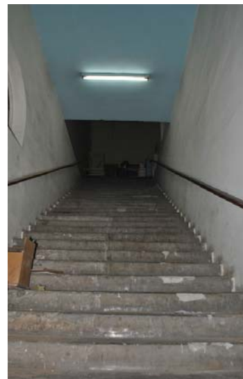
5.7. Escalera de hormigón
