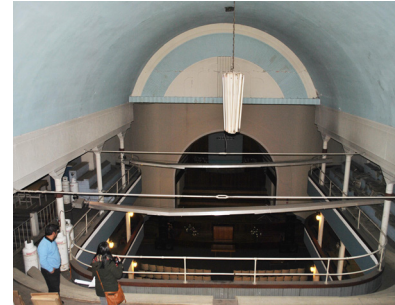
Malos sistemas de iluminación añadidos en el periodo del edificio como Templo Evangélico; lámpara y tubos fluorescentes colgantes.
