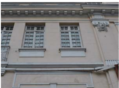
Fachada Volumen Foyer, con tratamiento en pintura y textura..
