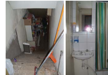
14. Nueva escalera y baño 2º nivel
