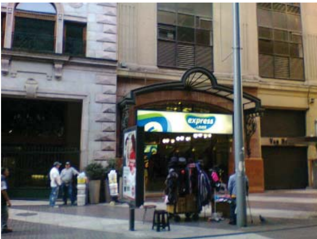
Fachada actual Teatro Victoria. Fuente: https://www.flickr.com/photos/patricio_l-c
