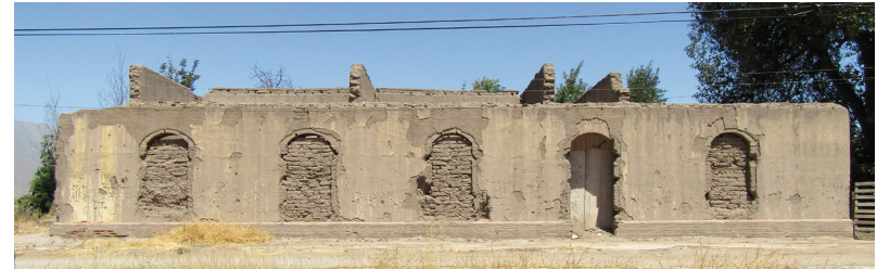
Estructura Ex-Estación. Fotografía Producción Propia.
