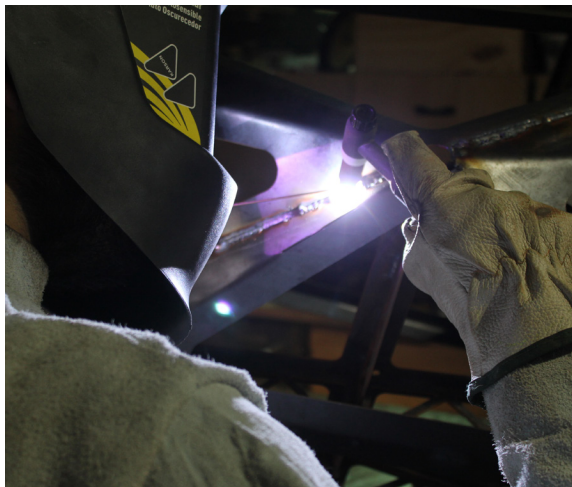
Imagen 58. Unión por soldadura TIG. Fuente: Elaboración propia.
