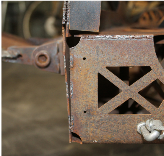
Imagen 64. Grieta izquierda plataforma base. Fuente: Elaboración propia.
