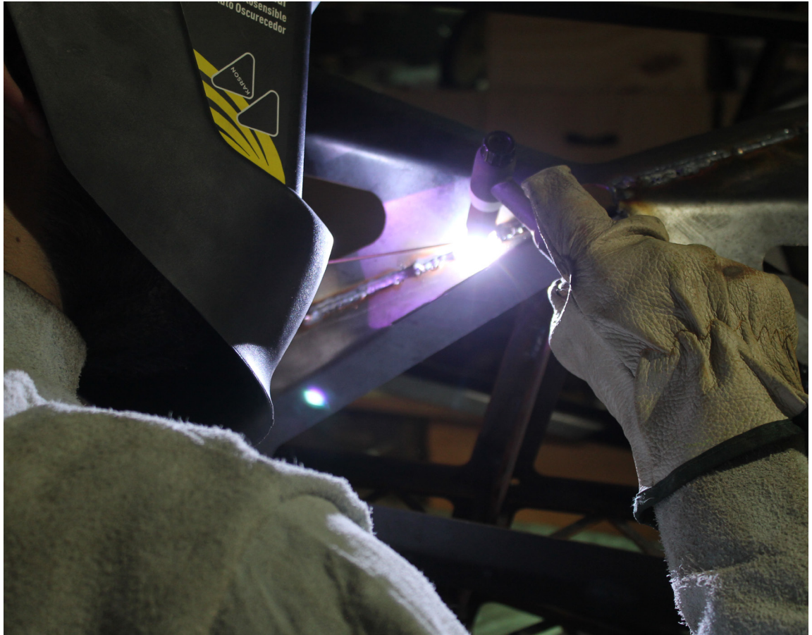
Imagen 36. Soldadura TIG Fuente: Elaboración propia.
