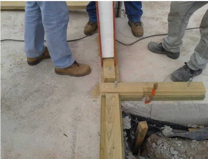
Figura 2: Ejemplo de anclaje a losa de sistema panel SIP
