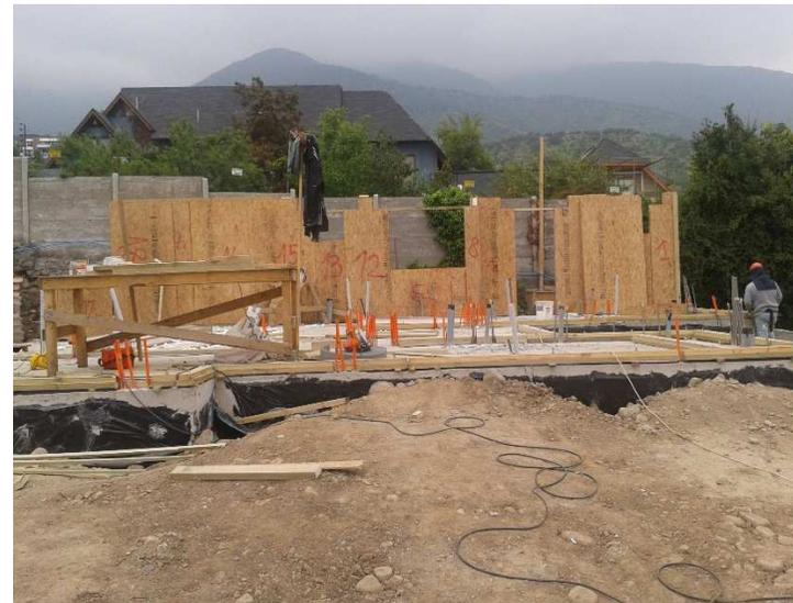
Figura 5: Clavijas para unión de paneles en sistema panel SIP
