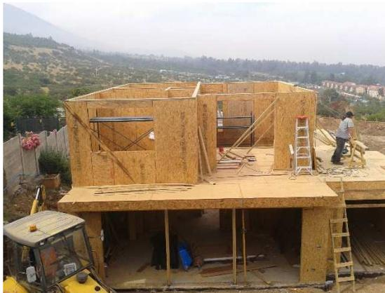
Figura 7: Casa fabricada con Panel SIP
