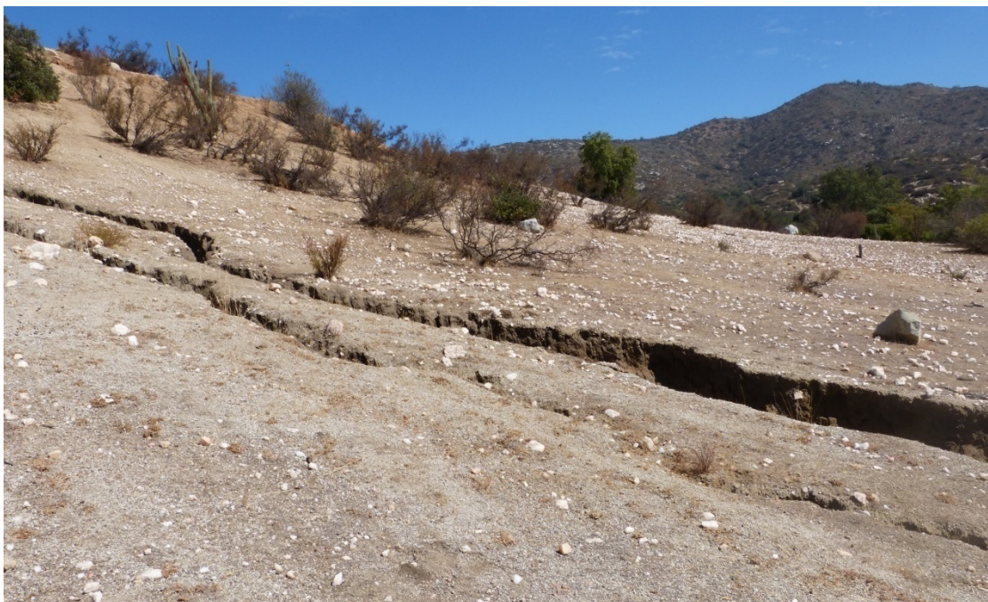
Cárcava erosiva en la ladera sobre el sitio.
