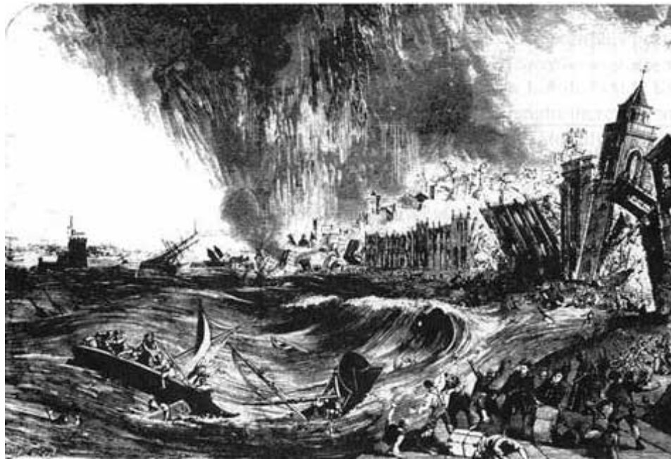
ILUSTRACIÓN N°3 Terremoto en Lisboa 1755 (Portugal) Fuente: www.elpais.com
