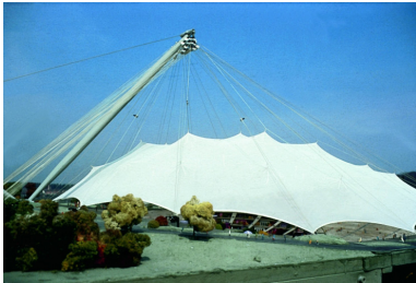
FREI OTTO Maqueta para techo desplegable http://www.freiotto.com/
