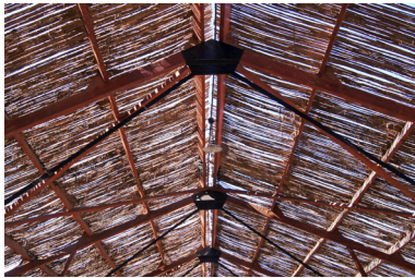
Mercado de María Elena Estructura de acero y madera revestida en caña ecuatoriana
