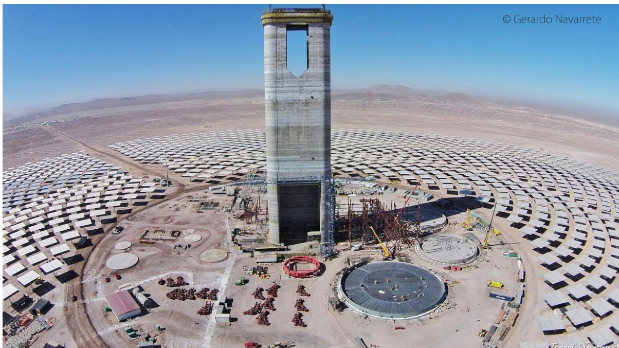
CSP Torre de Concentración Solar Fase de construcción 110 mW
