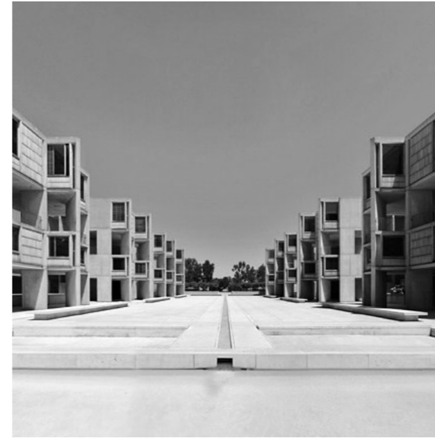
Louis Kahn, Salk Institute, USA. 1965. El agua como eje de proyecto, elemento a la vista que dirige la vista y el recorrido por el espacio jerárquico central.
