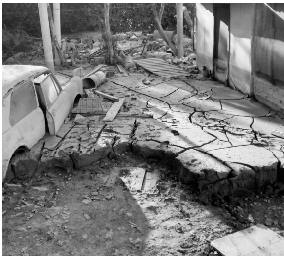
Figura 8. Autor. (2015). Nivel de barro desde 40 a 60 centímetros endurecido al exterior de las viviendas dañificadas. Copiapó, Chile.
