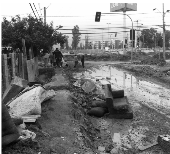
Figura 7. Autor. (2015). Intersección inundada y llena de escombros provenientes de las viviendas destruidas. Copiapó, Chile.
