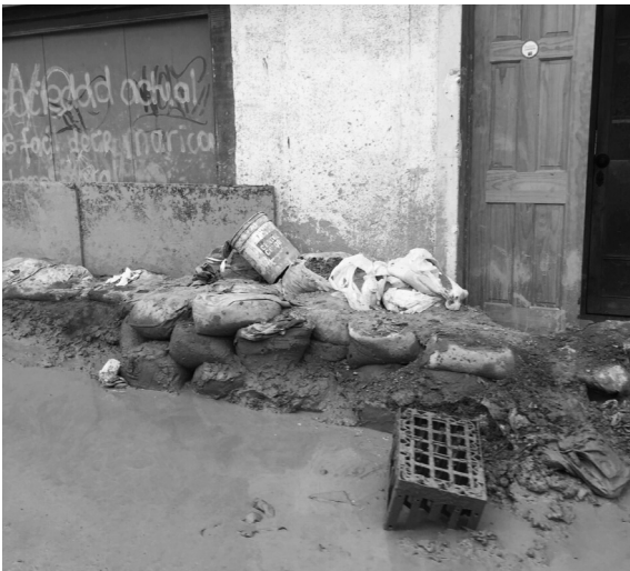
Figura 12. Autor. (2015). Fachada principal de una vivienda con inundación parcial. Copiapó, Chile.
