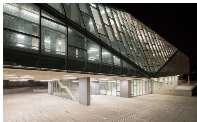
Aularios. Fuente: MARSINO Arquitectos
