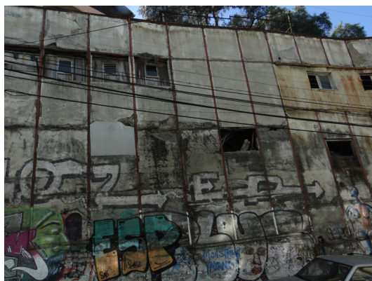
12 Zócalo Colegio Alemán Calle Almirante Montt / Fuente: E.P.
