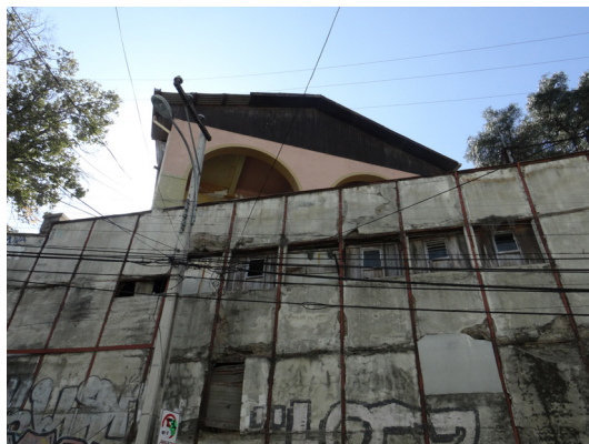
11 Zócalo Colegio Alemán Calle Almirante Montt / Fuente: E.P.
