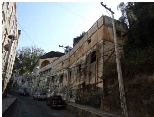
10 Zócalo Colegio Alemán Calle Almirante Montt / Fuente: E.P.
