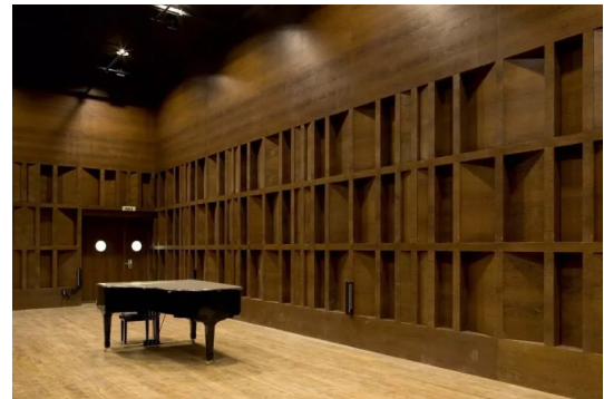
59 Tratamiento acústico salas de ensayo Conservatorio regional de música de Vila Real/ fuente: Divisare.it
