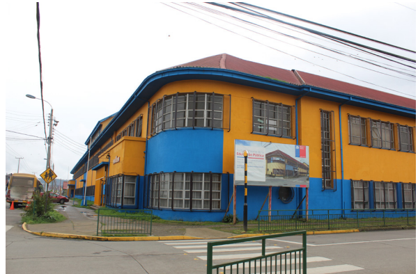
Figura 17: Colegio. Fuente: Elaboración propia.
