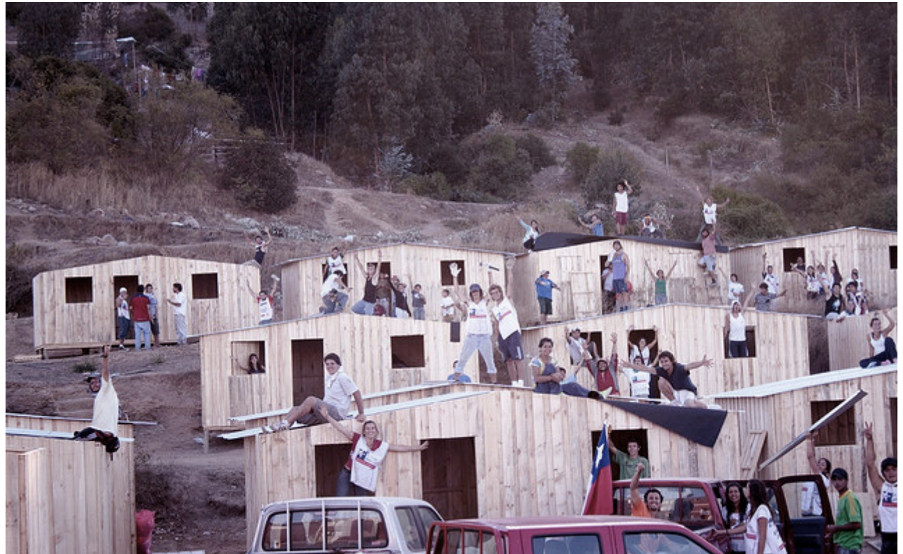
Voluntarios construyendo mediaguas, 2010 Fuente : http://blogs.lainformacion.com/laregladewilliam/2011/03/06/solidarios-en-accion-un-techo-para-chile/
