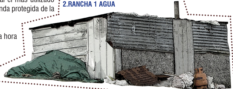
Estructura de madera revestida en cartón y planchas de zinc.
