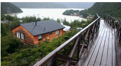
Pasarelas mojadas de Caleta Tortel tras la lluvia. (www.skyscrapercity.com)
