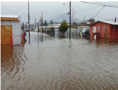
Sector afectado por inundaciones por lluvia en Puerto Aysén. (www.eldivisadero.cl)
