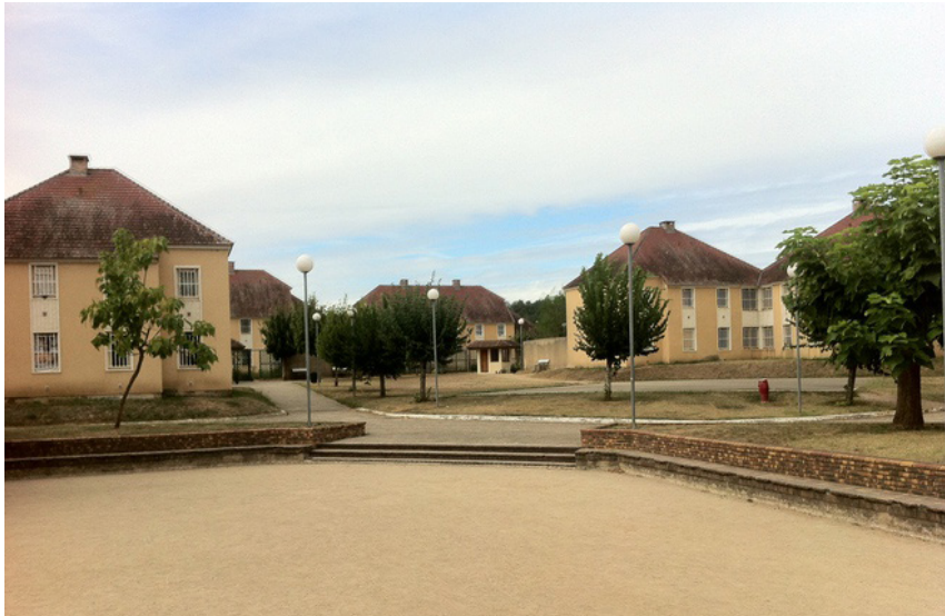
Fuente:Módulos penitenciarios de Mauzac-Wikipedia
