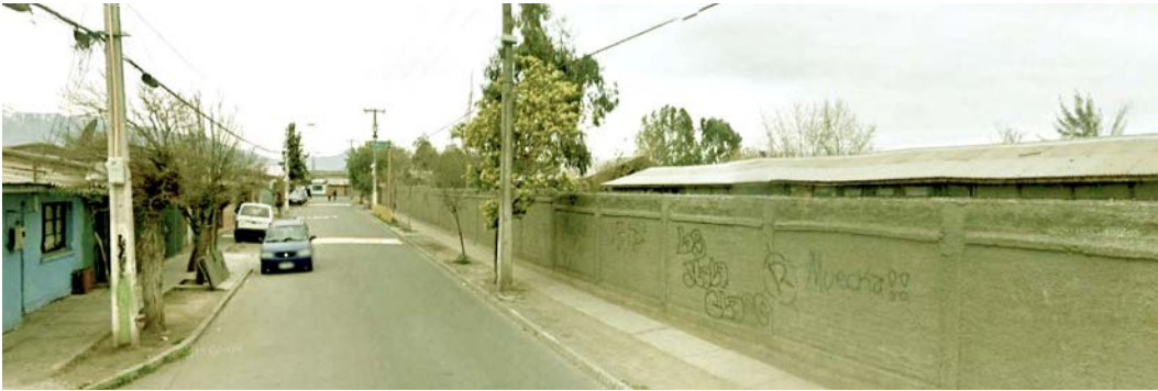
Cierre perimetral de la escuela Blue Star, por calle Managua Fuente: Google Earth, Street View
