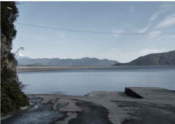
Rampas para barcazas Fuente: Fotografía propia, 2016
