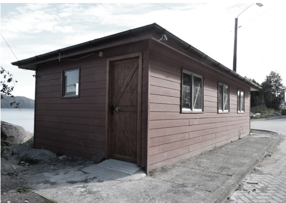
Sala de espera Fuente: Fotografía propia, 2016
