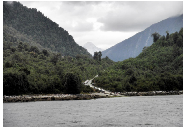
Fin del tramo de carretera en rampa de Fiordo Largo hacia Caleta Gonzalo. Fuente: Google Imágenes
