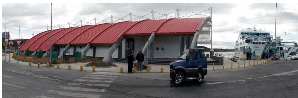
Terminal de pasajeros en Porvenir. Fuente: Google Imágenes
