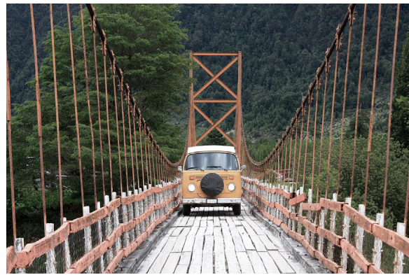
Puente en Villa Los Torreones, carretera austral. Fuente: Google Imágenes
