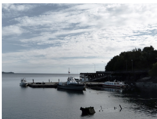
Puerto Fuente: Fotografía propia, 2016
