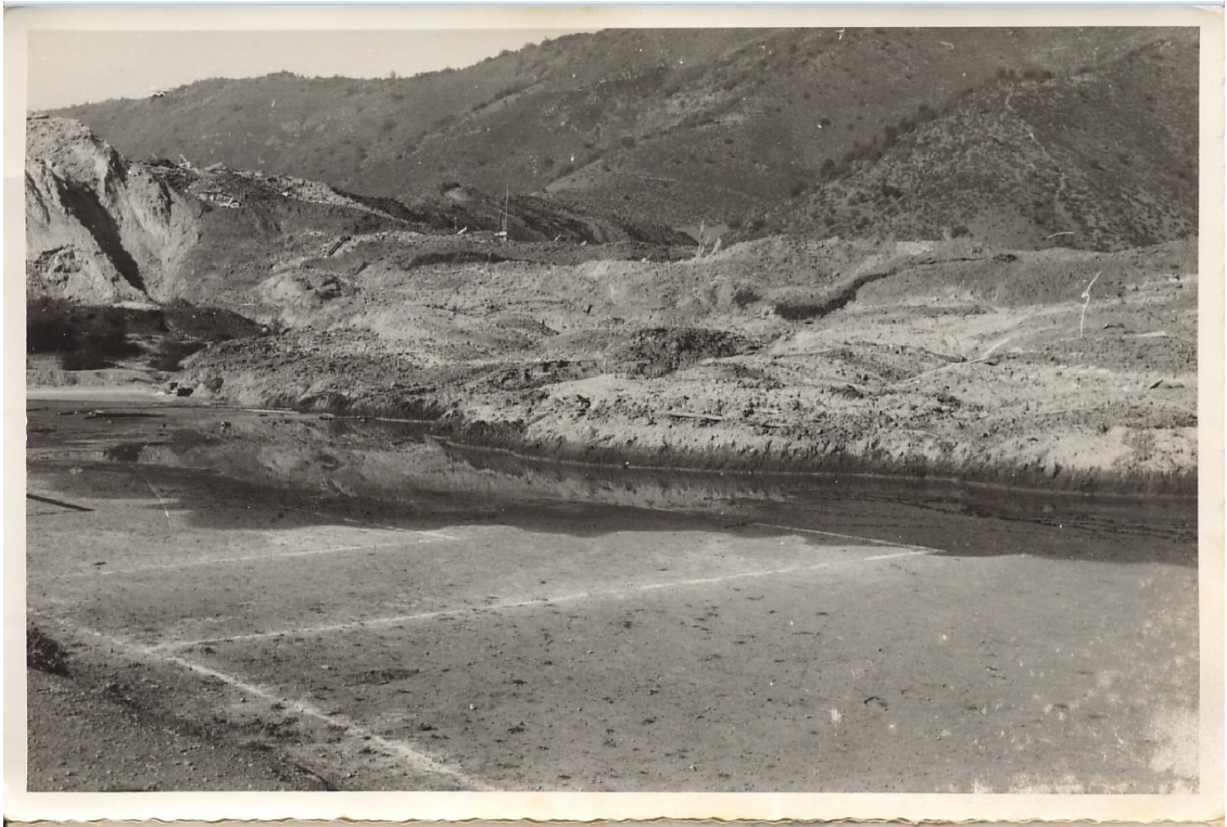
Sector La Cancha cubierta por el relave. Fuente familiar.
