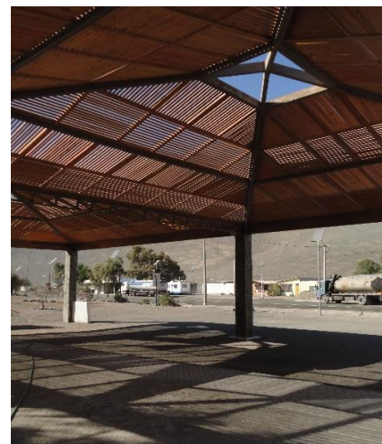
Imagen 26 (Arriba-Izquierda): Lógica constructiva en el desierto de Atacama a base de muros macizos y cubierta liviana. Fuente: Kapstein, G.; Espacios intermedios (1988).
