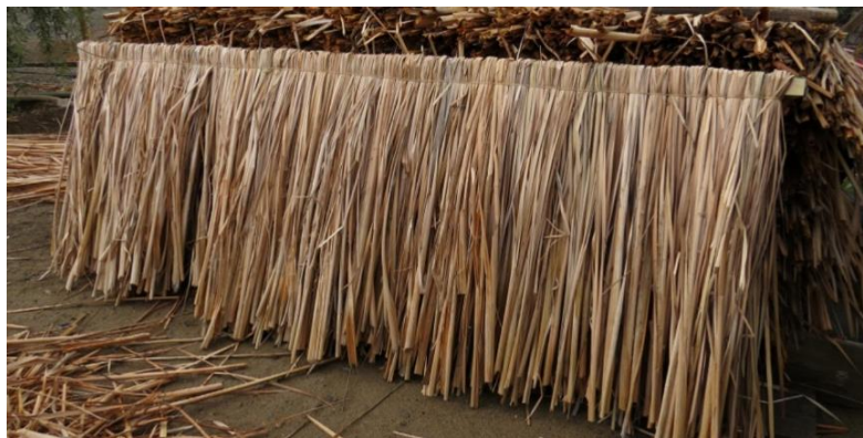
Imagen 28 (Arriba): Técnica constructiva de peineta de totora. Fuente: Cortés Godoy, D.; Sistemas constructivos locales como sistemas de conocimiento (2014).
