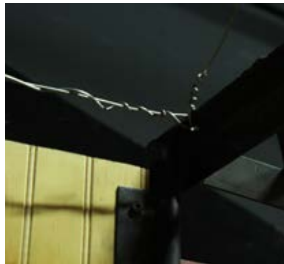
La imagen muestra la forma en que se aplicó la tensión mediante alambres de acero. Fotografía: Joaquín Veloso.
