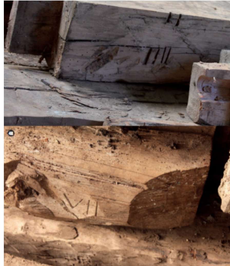
fig.21 : Piezas Numeradas de posible prefabricación en la Iglesia de Rilán Fuente: Investigación Iglesia de Rilán: indicios de prefabricación en la Escuela Chilota de arquitectura en madera. Revista De Arquitectura 29 Tradiciones, Traducciones y Transferencias 2013-2014. por Macarena Almonacid,pág 28-29.
