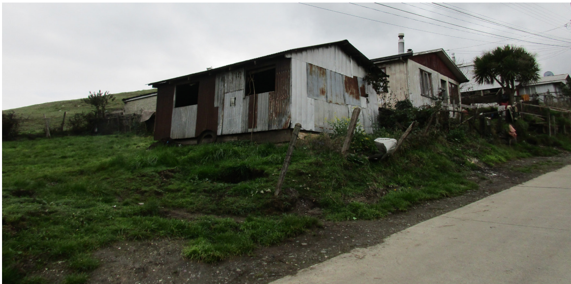
fig.41: Vista inferior viviendas actuales calle Javiera Carrera Junio, 2016 fuente: Elaboración propia
