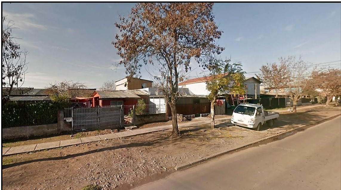
Viviendas de Villa Francia ubicadas en la calle Luis Infante Cerda. Estación Central. Su construcción comienza durante la operación sitio. Fuente: Google Street View, 2016.
