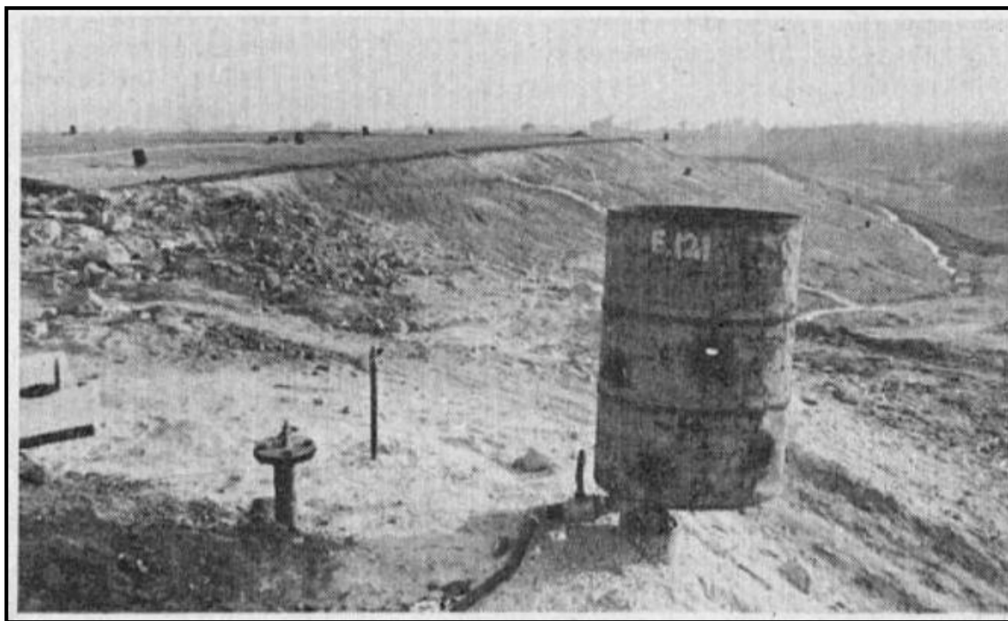
Quemadores de gas metano instalados en relleno sanitario Lo Errázuriz Fuente Revista Solidaridad, 1987.
