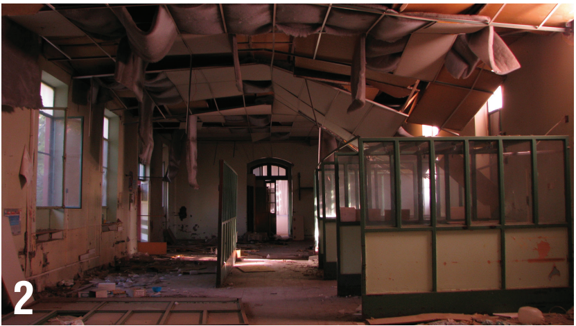
Pabellón central clínica
