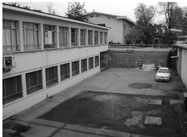
Figura 69: Espacio resultante entre bloques del Instituto Dr. Horwitz Barak. Fuente: Fotografía del autor, 2013
