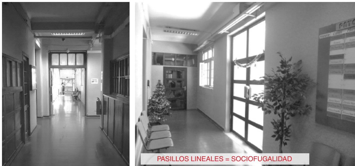
Figura 96: Pasillos de edificio IRM de Medicina General y Patología Dual. Fuente: Fotografía del autor y extraído de “Cuenta Pública Hospital Psiquiátrico El Peral”, MINSAL, 2015
