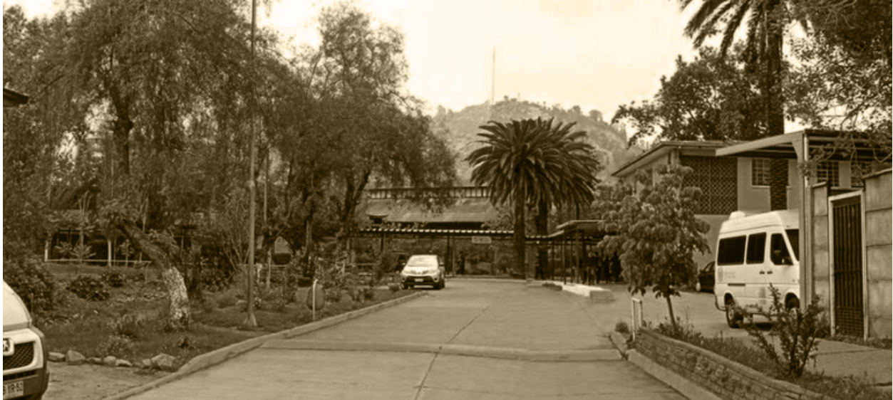
Figura 60: Vista general patio interior Instituto Psiquiátrico Dr. Horwitz. Fuente: http://www.psiquiatico.cl
