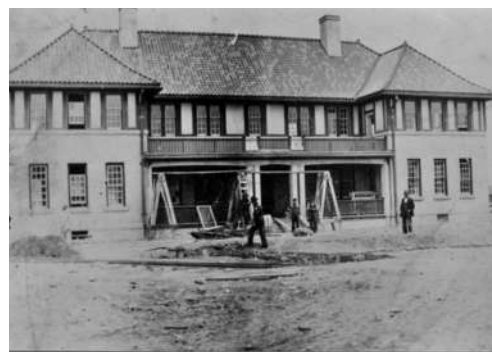
Cabaña en construcción, Hospital Ontario Whitby, 1916
