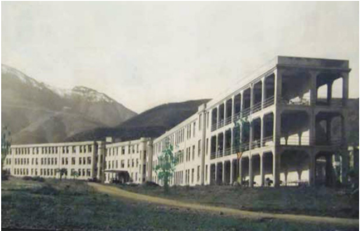
Figura 57: Vista general del Sanatorio de Putaendo en fase de construcción, década de 1940. Fuente: Extraído de "La Psiquiatría en Chile, apuntes para una historia", 2010
