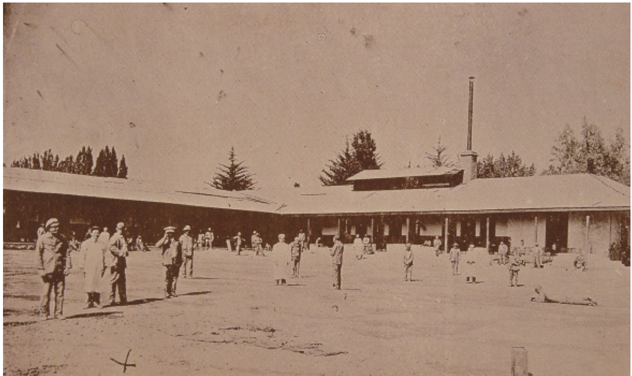
Figura 54: Construcciones del Open Door - La cocina central y dependencias. Fuente: Cuenta Pública Hospital Psiquiátrico El Peral, MINSAL, 2015
