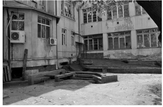
Antes de la restauración
