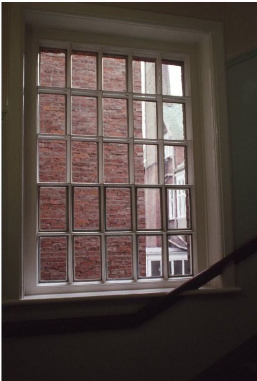
Ventana con uno de los estilos originales del York Retreat, que emulaba a una ventana con barrotes doméstica, pero que contenía barras de acero ocultas para contener a los pacientes. Fuente: https://www.historic-hospitals.com
