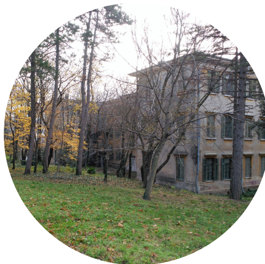
Figura 43: Edificaciones aledañas al Centro de Salud Mental. Fuente: http://www.miresidenciadesaludmental.blogspot.cl
