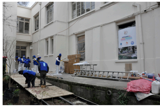
Restauración del espacio
