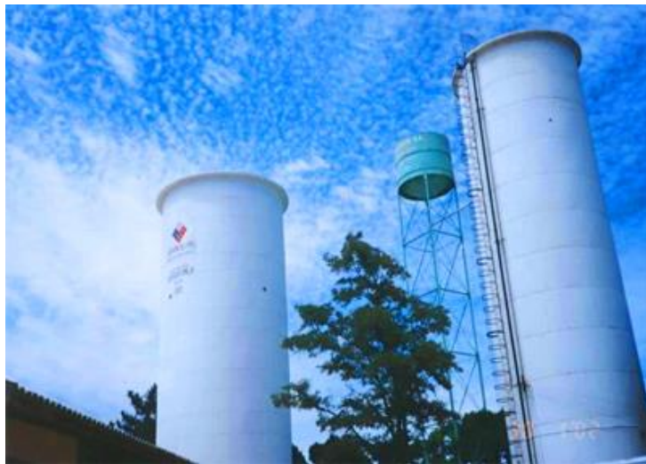
Imagen 4: Sistema de Agua Potable Rural Fuente: www.intranet.doh.cl
