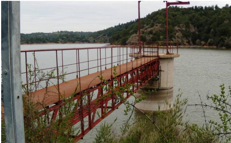
Torre de captación (Fuente: Fotografía del autor)
