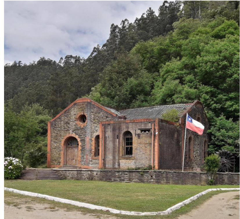
Central Hidroeléctrica Chivilingo, Lota (Fuente: Fotografía del Autor)
