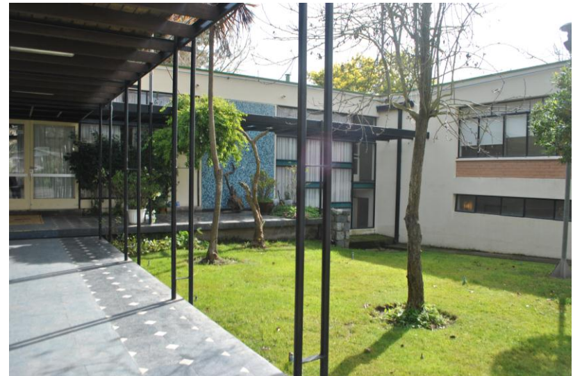
Casa de Huéspedes (Fuente: Fotografía del autor)
