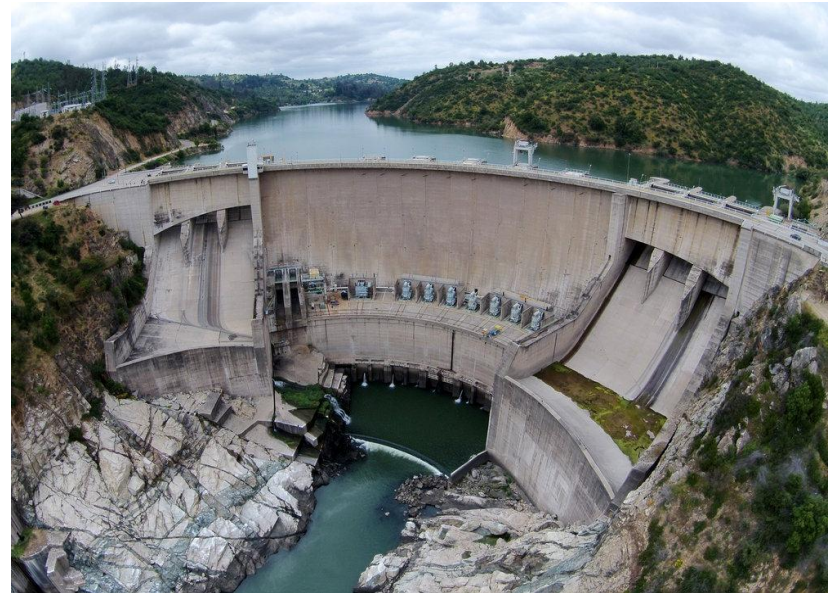
Central Hidroeléctrica Rapel (Fuente: http://www.lofscapes.com/ )
