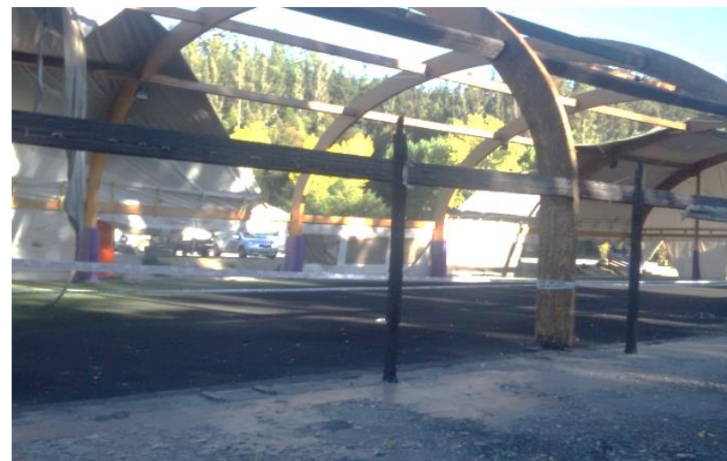
Foto N° 47. Vista cancha techada, del autor 2015.
