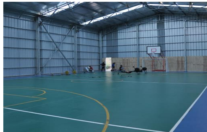
Foto N° 31. Vista cancha techada, del autor 2015.
