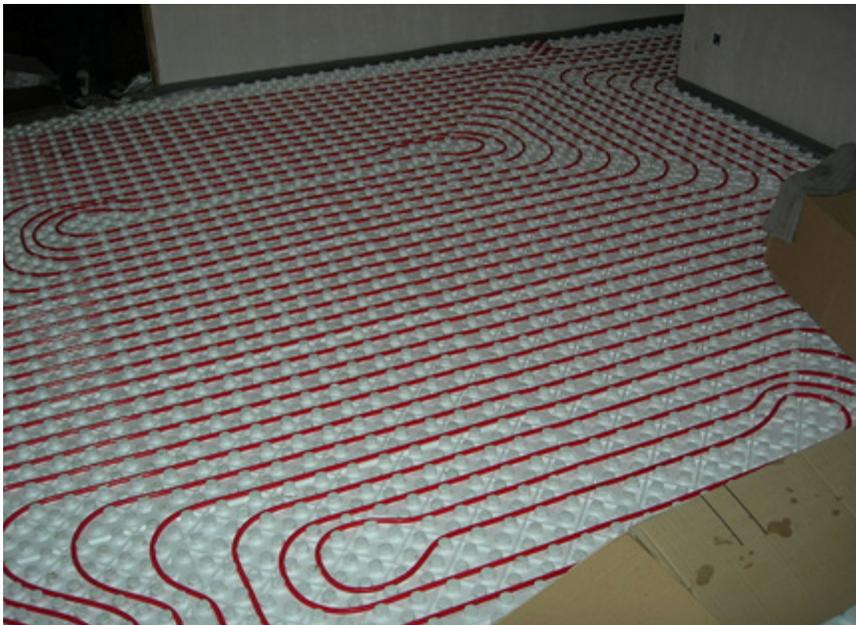
La gran ventaja de este sistema de calentamiento es que incide sobre la temperatura resultante, en la que intervienen la temperatura radiante media y la temperatura seca del aire, de modo que, en este caso, al haber una temperatura radiante media más alta, puede bajarse la temperatura seca del aire dos o tres grados, disminuyendo en esa medida las pérdidas de calor del local hacia el exterior, sin disminuir las prestaciones en cuanto a comodidad térmica (sensación térmica).
