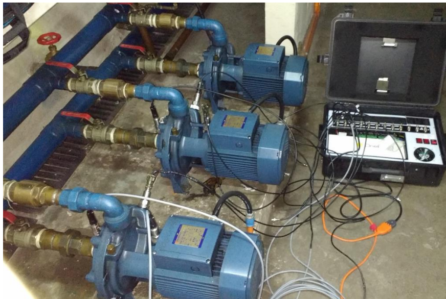
Figura 4-1 Prueba de equipo en instalación de bombas [Elaboración propia]
