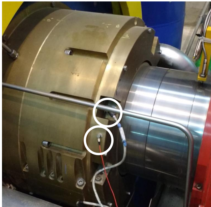
Figura 4-54 Instalación de acelerómetro y sensor de emisiones acústicas en descanso de turbina [Elaboración propia]
