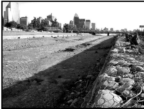
Vista de la ciudad desde la carretera que conduce al sector de Lo Curro, borde norte el Mapocho.
