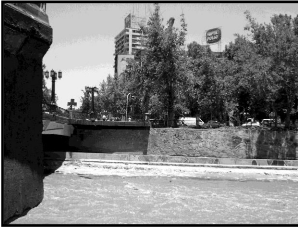
Canalización en el sector del puente
