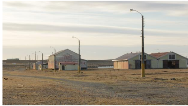
Fig. 19: Bodegas de almacenamiento, Puerto Percy. Fotografía: Pía Acevedo, 2015.
