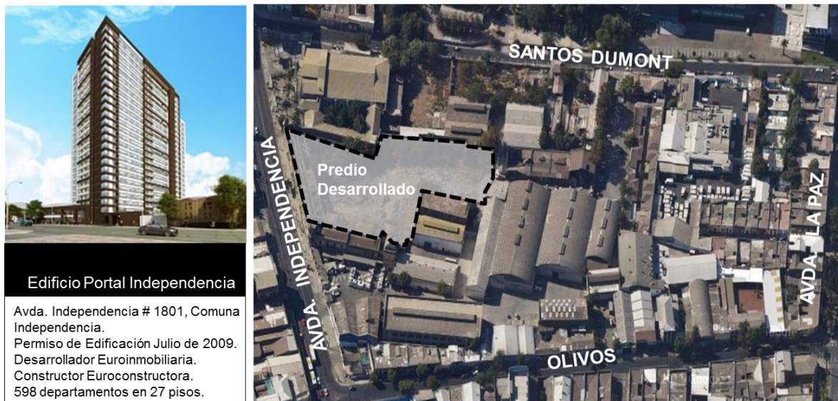
Figura 3. Caso de Normativa Permisiva. Edificio Portal Independencia, comuna Independencia. Fuente: Elaboración propia.
