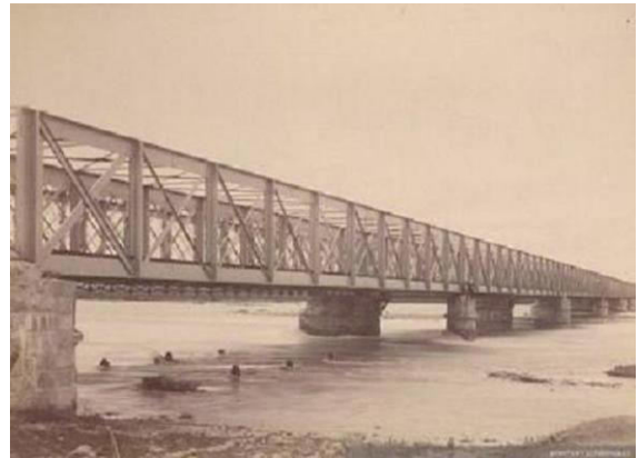
Puente Ferroviario sobre el río Maule. Archivo Fotográfico y Digital, Biblioteca Nacional
