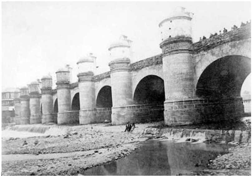
Puente Cal y Canto
