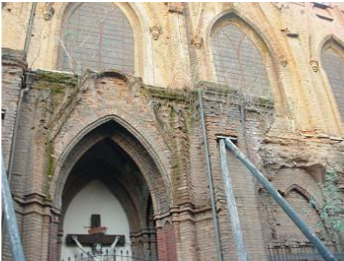
Los muros caídos en el terremoto de 1985 fueron reemplazados por unos de hormigón y pintados simulando el ladrillo
