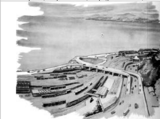
Fig.111. Autopista de Valparaíso a Viña del Mar. Vista del entronque proyectado con la Avda. España a la altura de la Estación Barón, mediante trébol que cruza por paso superior, los desvíos de la Estación Barón. Uno de los ramales del trébol conecta a la Costanera y el otro con la Avda. Argentina y Santos Ossa, salida directa a Santiago.
