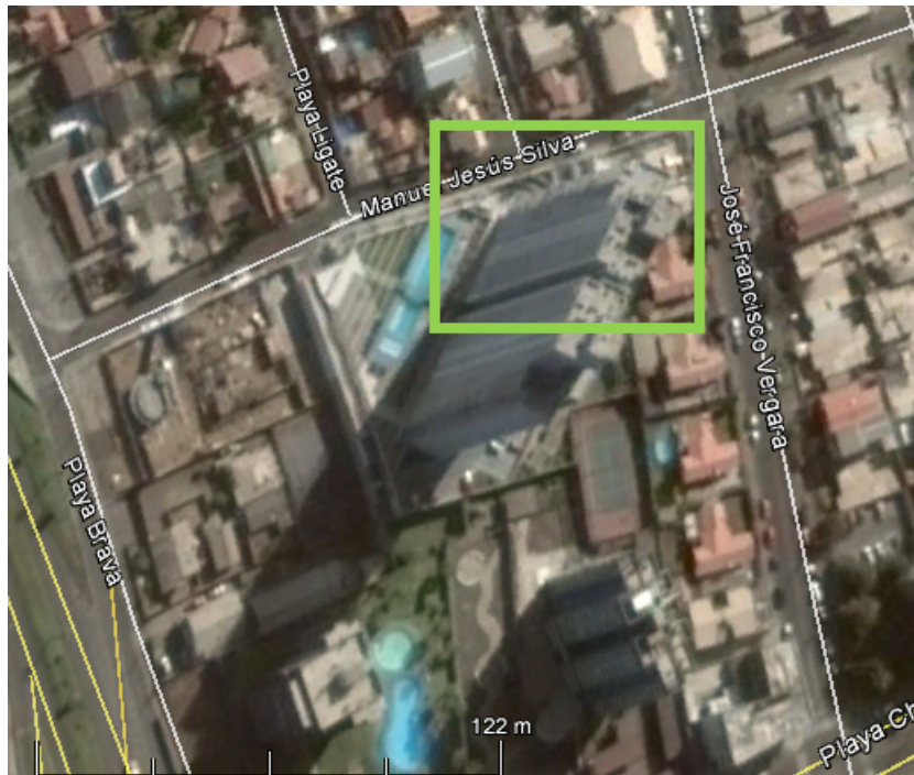
Figura 3.1: Vista aérea sobre la Torre A (recuadro verde). Fuente: Google Earth, 2016.
