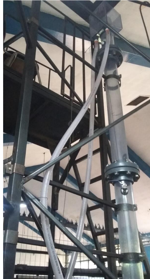
Figura 31: Columna 3-D (parte superior). Posee contenedor de espuma unido a mangueras de descarga de rebalse.
