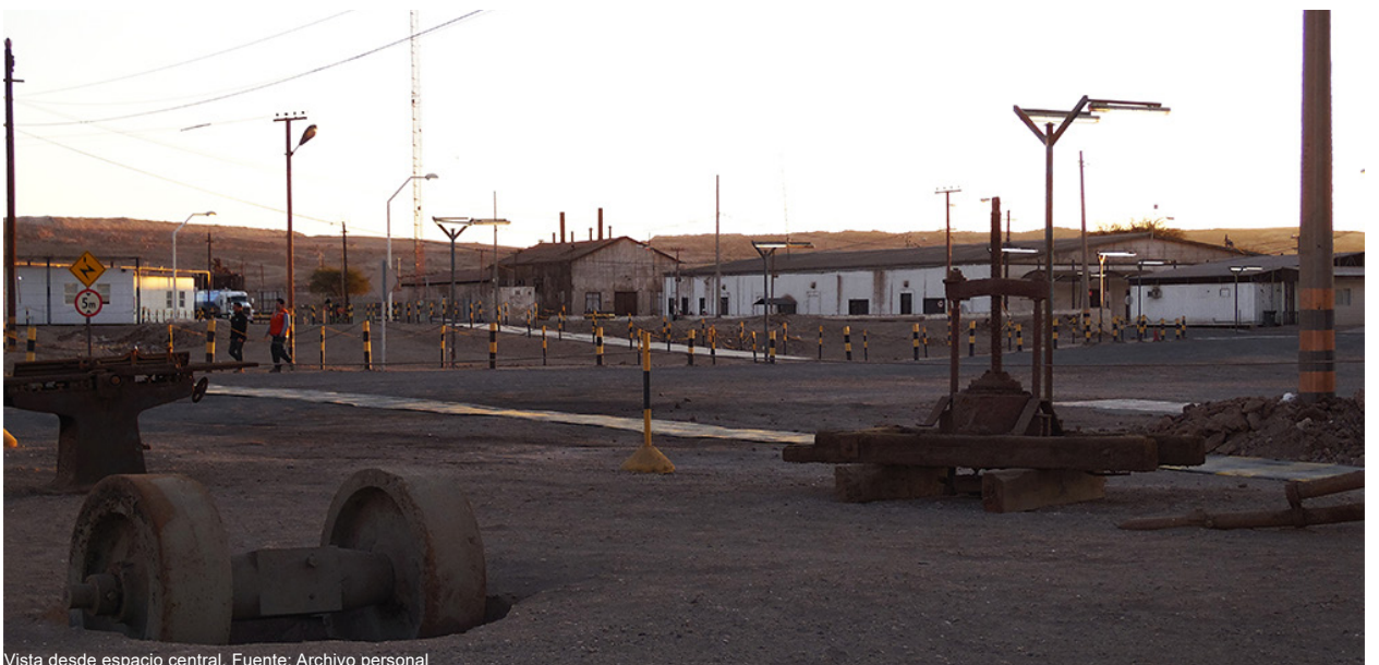
Vista desde espacio central, Fuente: Archivo personal
