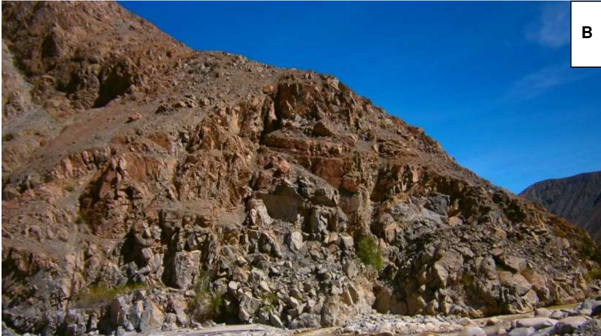
Figura 3.5: a) Intrusivo Lluta, fracturado, orientación NE. b) Intrusivo Lluta cubierto de material coluvial, orientación SW. Fuente: Elaboración propia.
