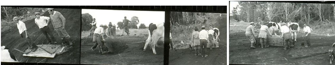
Campesinos de Calen en la construcción del camino de Calen a camino de cintura. 1977
