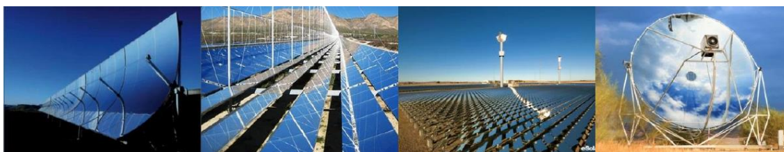
Figura 8 Tecnologías de concentración, de izquierda a derecha: Espejos Parabólicos; Fresnel; Torre Central; Disco Stirling [6]
