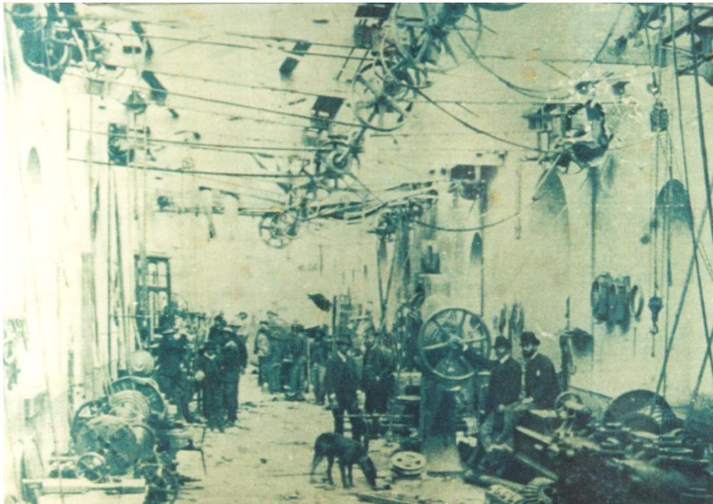
Imagen: interior de maestranza sin identificar. En la imagen se ve el mecanismo de ejes y correas que hacía mover los bancos de trabajo, accionado por una máquina a vapor estática, s/a, s/f.
