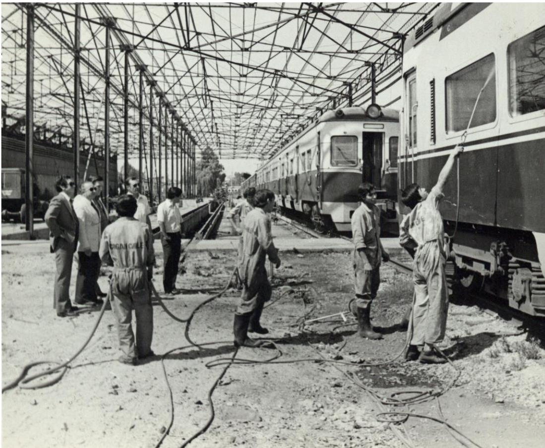
Imagen: Taller de lavado de automotores en la MSE (en primer plano un AEZ y en segundo un AES), s/a, s/f. Fuente: Archivo Revista en Viaje.
