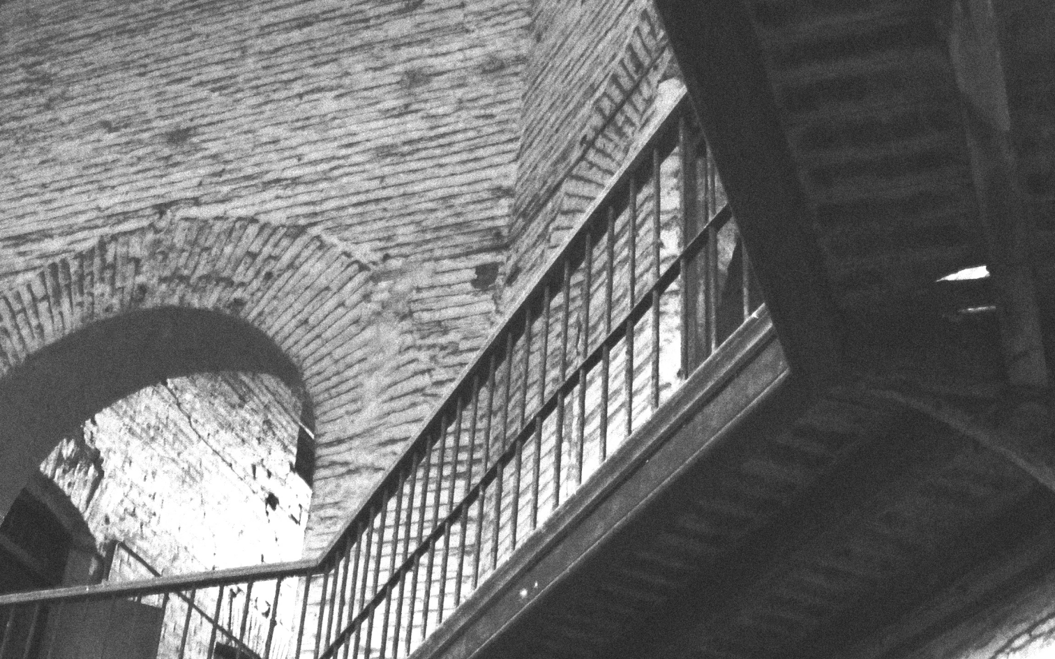
Corredores del segundo piso al interior de la Ex Cárcel de San Fernando Fuente: Elaboración propia
