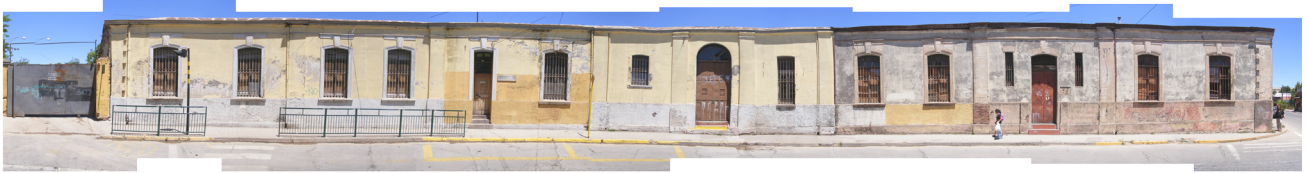
Fig.36 Levantamiento fotográfico de la fachada norte. Fuente: Elaboración propia
