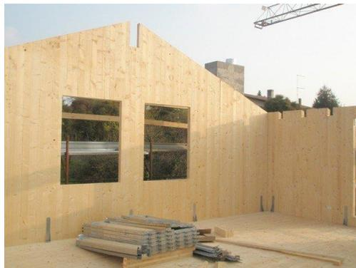
*Fig.2. Proceso de montaje de casa con sistema de placas CLT*
