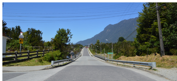
Foto 53: Vista Calle Cordillera
