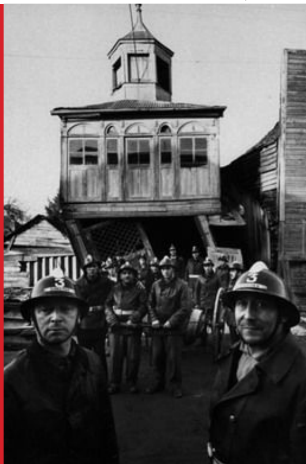
Foto 8: Bomberos de Castro frente a su cuartel post terremoto 1960 Fuente: www.simbolospatrios.cl
