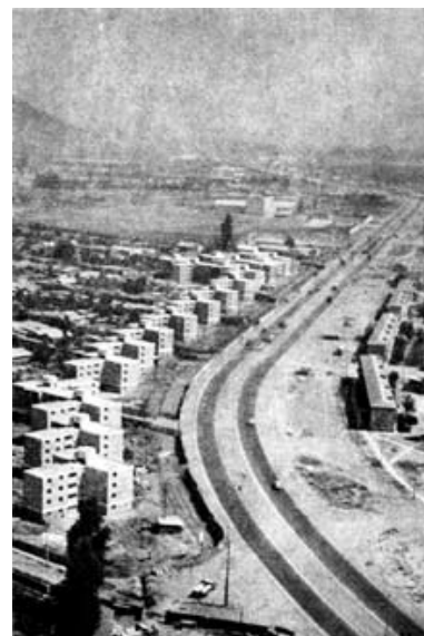
FIGURA 2. Fotografía vista general del sector 2-B población Juan Antonio Ríos, conjunto de vivienda construido a partir del D.F.L. n°2. FUENTE: Chile, un siglo de políticas de vivienda y barrio, 2004.
