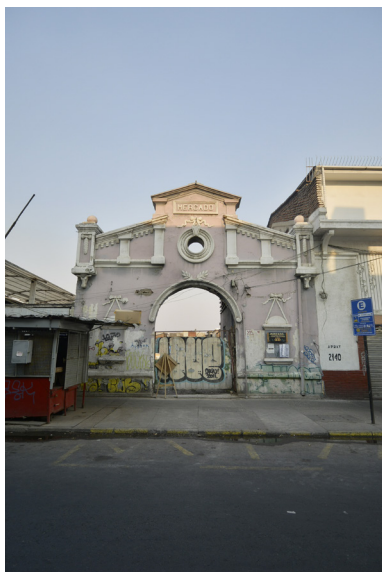
FIGURA 4. Fotografía estado actual edificio Mercado Matadero, vista desde la calle Arturo Prat. FUENTE: Elaboración propia.
