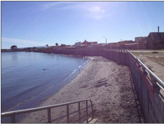
MURO DE CONTENCIÓN / COSTA PUERTO SAAVEDRA Fuente: Propia, abril 2016
