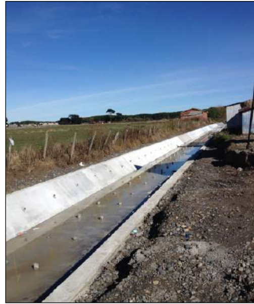
CANALIZACIÓN CANAL 21 DE MAYO DESBORDES Y/O INUNDACIONES POR CRECIDAS POR FUERTES LLUVIAS Fuente: Propia, octubre 2016
