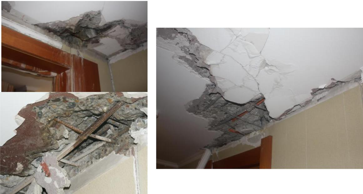
**Figura 5.12** Losa – Daño en piso 1
