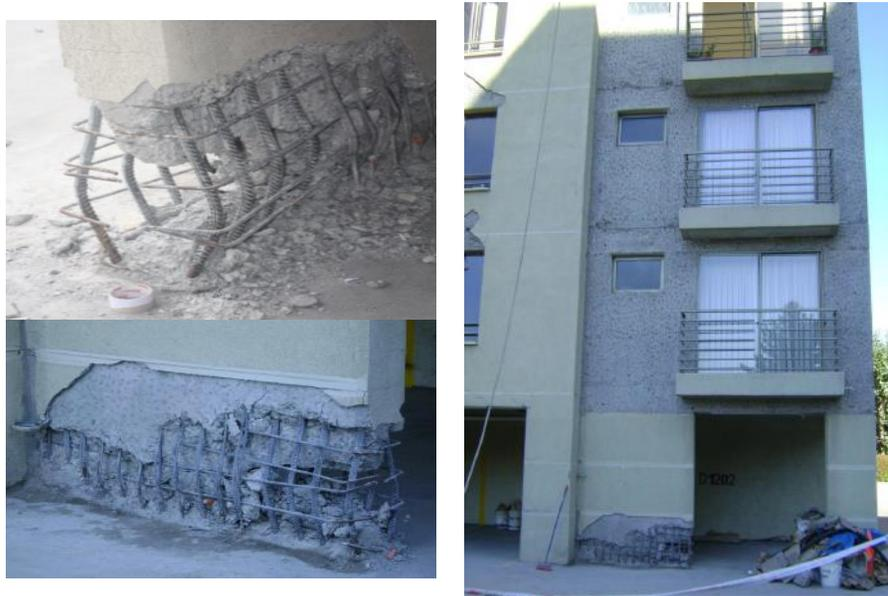
**Figura 5.11** Muro Y7 – Daño en piso 1
