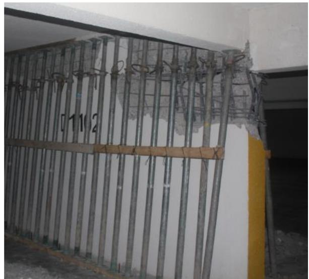
**Figura 5.10** Muro Y6 – Daño en subterráneo 1
