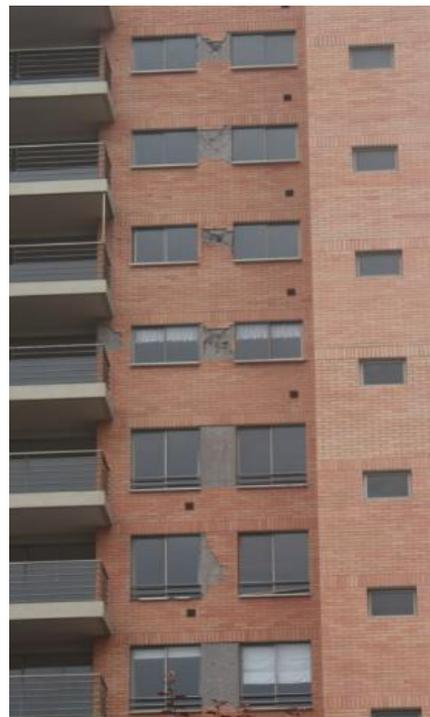
**Figura 5.8** Muro X17 – Daño en fachada norte
