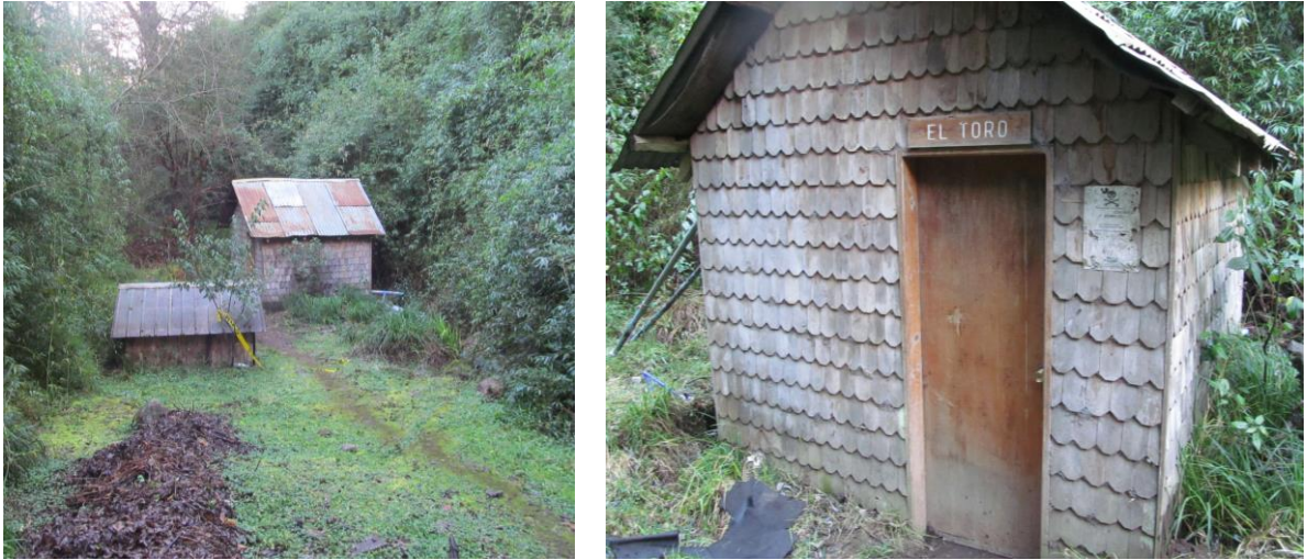
Figura 2-6: Caseta que contiene el pozo en el cual se realizó el muestreo del área termal San Luis. Esta se encuentra en una quebrada ubicada al costado del recinto turístico.
