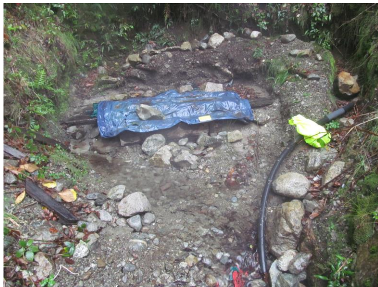
Figura 2-19: Pozo artificial (cubierto) en el cual aflora agua termal de forma natural, la cual es canalizada por tuberías hasta las instalaciones turísticas.
