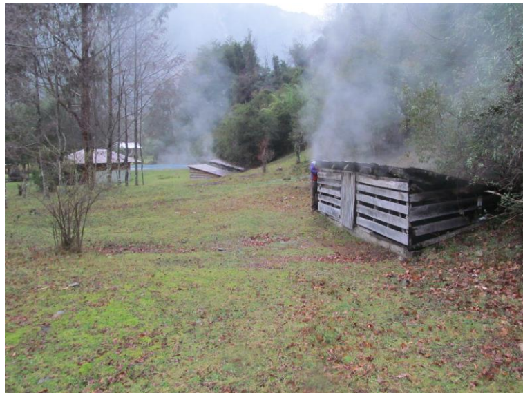
Figura 2-12: Casetas que recolectan la surgencia de agua natural en el área termal Pellaifa. Existen tres casetas ubicadas en la base del cerro colindante al área termal.
