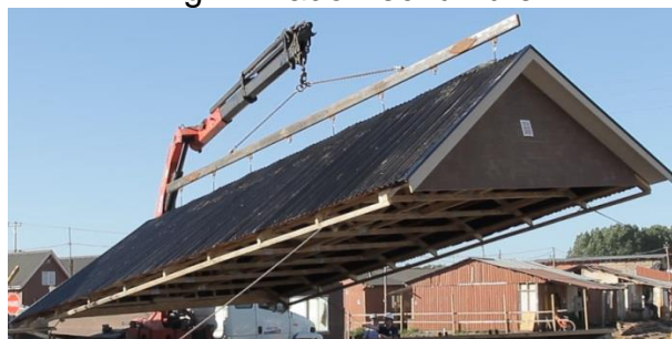
Fig. Armado Techumbre
