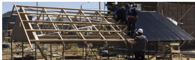
Fig. Armado Techumbre
