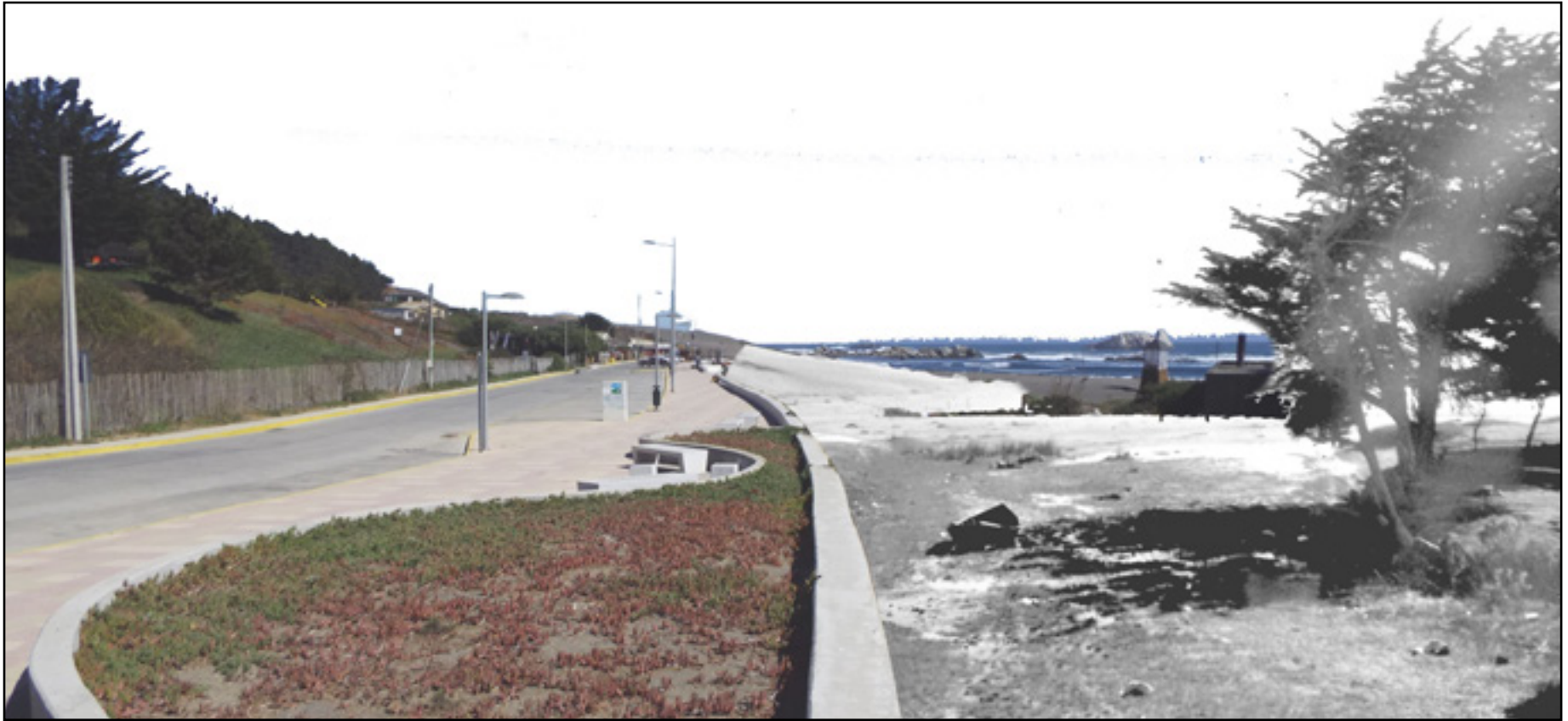
Imagen N°1, Comparacion sector del Puente 1985 - actualidad, Elaboración propia.
